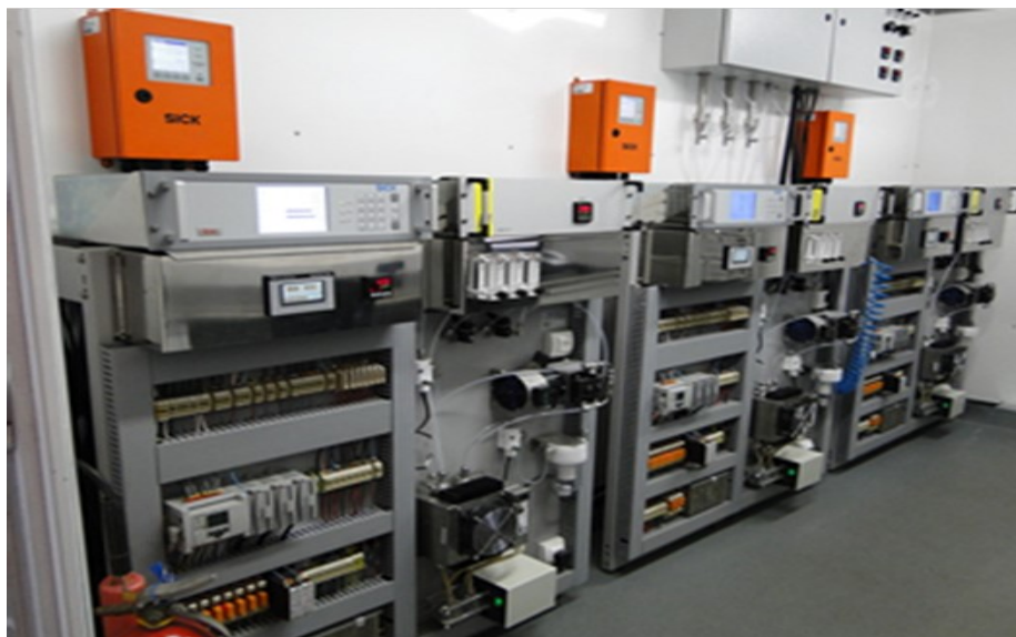
Figura 6. CEMS da UTE Candiota III Fase C.
