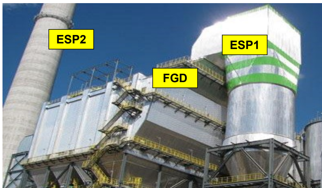
Figura 4. Sistema de tratamento de gases da UTE Candiota III Fase C.
